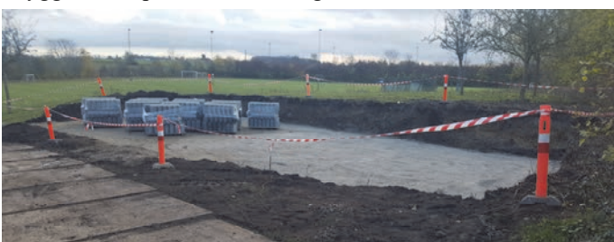
Den ny containerplads på bagsiden af hallen.
