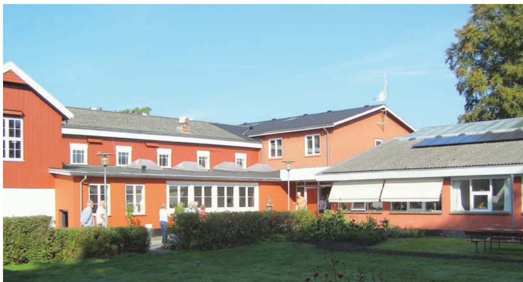
Bornholms Højskole - funktionel og æstetisk trods ombygninger og tilbygninger.
