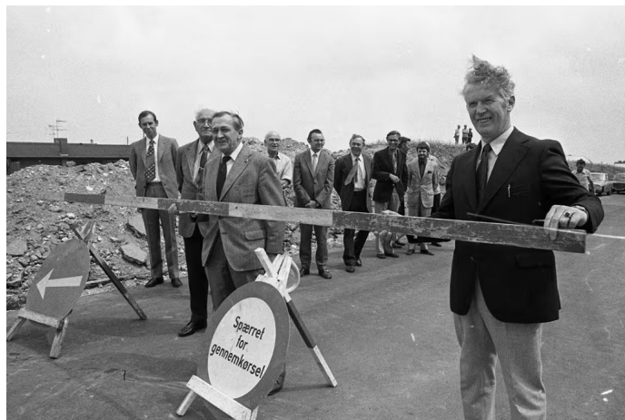
Åbning af omfartsvejen ved Sengeløse - endnu en vigtig ting at få på plads inden sammenlægningen med Høje Taastrup. Foto: Arkiv.dk
