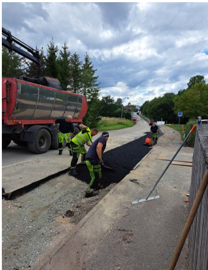
Her knokles der lørdag eftermiddag med at lægge asfalt på strækningen foran skolens parkeringsplads for at gøre klar til skolestart
